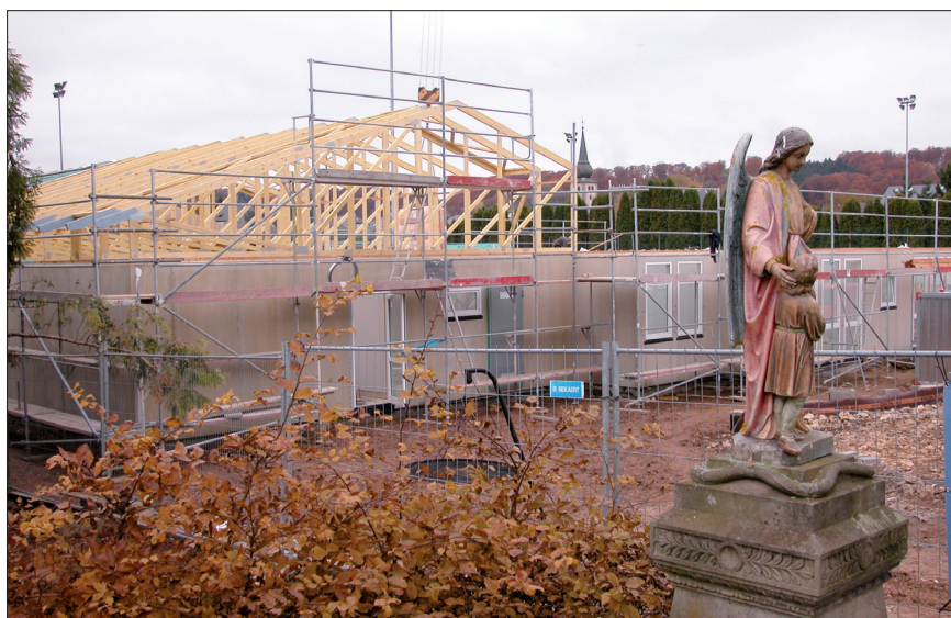
Les travaux de construction vont bon train
