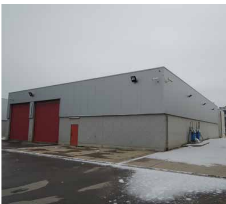
Neuer Raum für die technischen Dienste der Gemeinde, vormalig Hall Barthelmé
